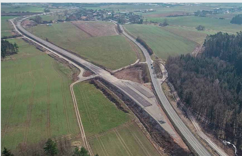
Der Bau der neuen Ortsumfahrung Sommerau ist inzwischen weit fortgeschritten. Ab 31. März wird die neue Trasse nun an den bestehenden Rehau-Kreisverkehr und, wie auf dem Foto zu sehen, gegenüberliegend an die Staatsstraße 1066 angebunden. Die Verkehrsfreigabe soll bereits im Sommer erfolgen. (Foto: Werner Tippmann)
