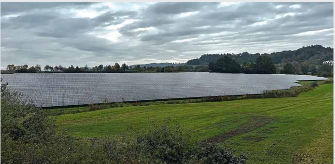
Der erste Solarpark, der im Sommer 2023 von der nahKRAFT GmbH der Stadtwerke Feuchtwangen in Kooperation mit REHAU errichtet wurde, ist nun offiziell ans Netz gegangen.
