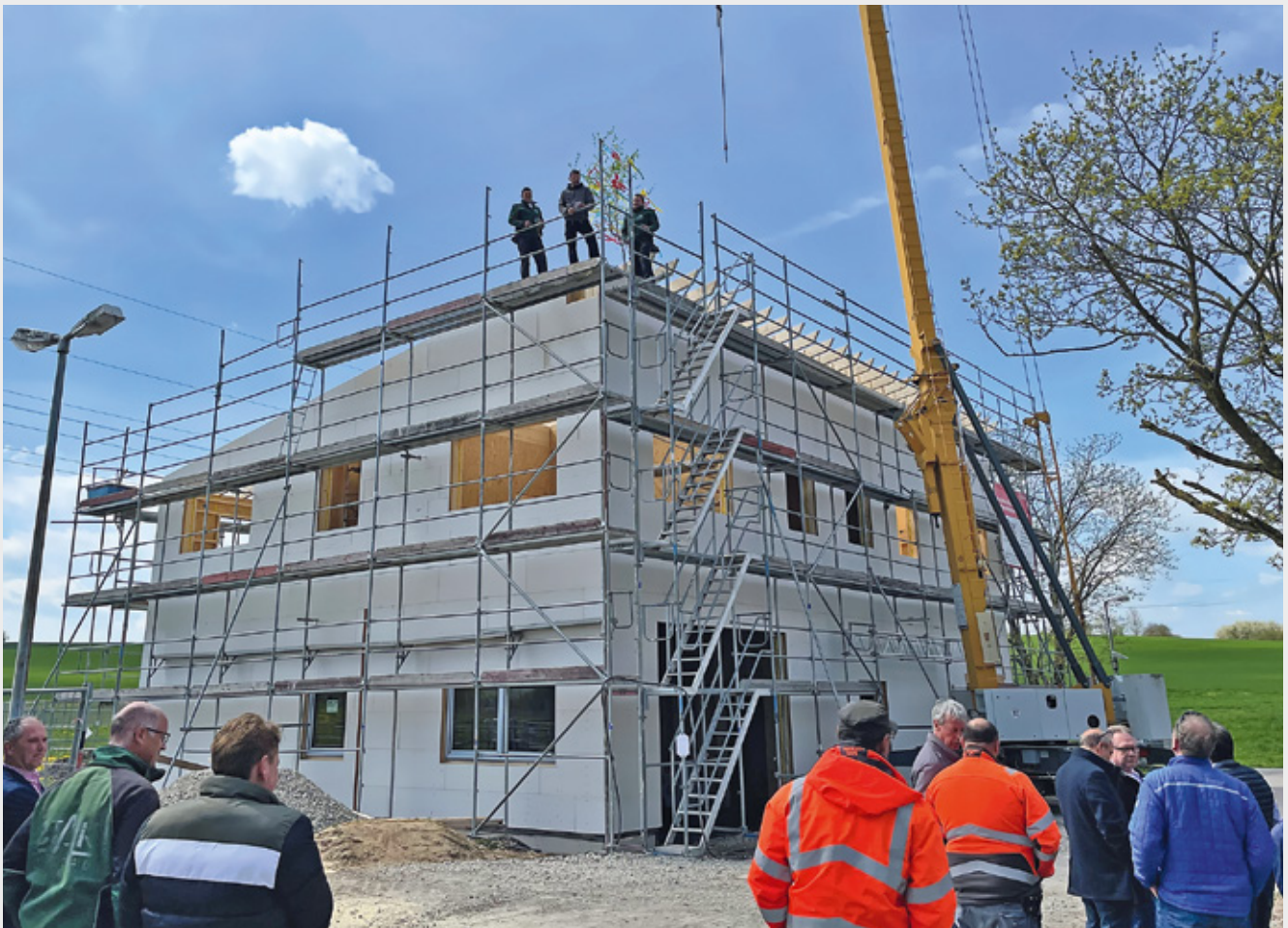
Der Rohbau und der Dachstuhl für das neue Betriebsgebäude der Kläranlage in Feuchtwangen sind fertig. Ende April feierten die Beteiligten nun Richtfest.
