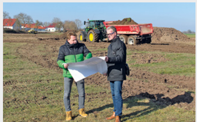
Feuchtwangens erster Bürgermeister Patrick Ruh (rechts) und Holger Hutmann vom städtischen Tiefbauamt informierten über die Planungen zum neuen Baugebiet „Hochschule“ in Feuchtwangen. Im Hintergrund laufen bereits die ersten Erschließungsarbeiten.
