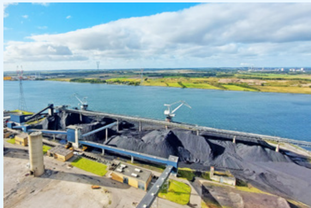
Noch lagert Kohle am Kraftwerk in Nordjyllandsværket – Bis 2028 will der Betreiber vollständig auf erneuerbare Energien umstellen.
