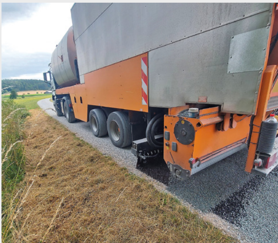
Die Stadt Feuchtwangen ertüchtigt ihre ausgeschilderten Radwege. Mit einer doppelten Oberflächenbehandlung, bestehend aus zwei Schichten Bitumen und Splitt, wurden die betroffenen öffentlichen Feld- und Waldwege nun geebnet und befestigt.
