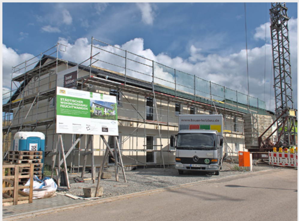
Im Baugebiet „Röschenhof“ steht seit einigen Wochen bereits das zweite neue Mehrfamilienhaus der Stadt Feuchtwangen. Ende des Jahres soll das Objekt laut Zeitplan schlüsselfertig an die Stadt übergeben werden.
