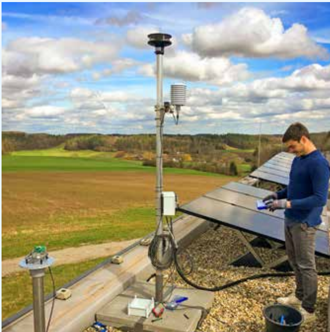
Thomas Haupt bei der Montage der Wetterstation auf dem Dach des Forschungsgebäudes am Campus Feuchtwangen.
