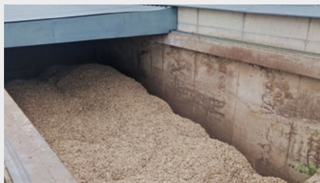
Seitdem wird der Speicher des Biomasseheizwerks am Schulzentrum jährlich mit rund 3.000 Schüttraummeter an Hackschnitzeln aus dem städtischen Wald und nahem Umfeld gefüllt.
