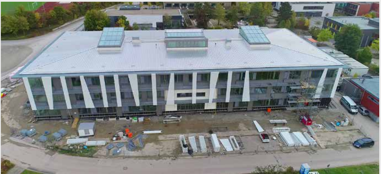
Derzeit werden die letzten Streckmetallelemente entlang der Fassade montiert. Innen wie außen laufen die Arbeiten an der neuen Grund- und Mittelschule Feuchtwangen-Land auf Hochtouren. (Luftaufnahme © Werner Tippmann)
