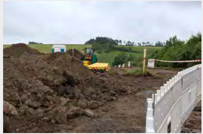
Im Bereich der geplanten Westtangente wurde kürzlich mit der Verlegung einer Gashochdruckleitung begonnen.
