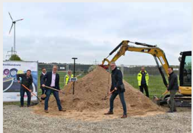
Das dritte Verfahren im Feuchtwanger Breitbandausbau hat begonnen. Den symbolischen ersten Spatenstich setzten (von links): Florian Frey von den Stadtwerken Feuchtwangen und der Technische Werkleiter Lothar Beckler, Geschäftsführer des Netzbetreibers Johannes Bisping, Bauleiterin Merle Belusa, Bürgermeister Patrick Ruh, Alexander Aretz vom Planungsbüro sowie Stadtrat Thomas Ackermann.
