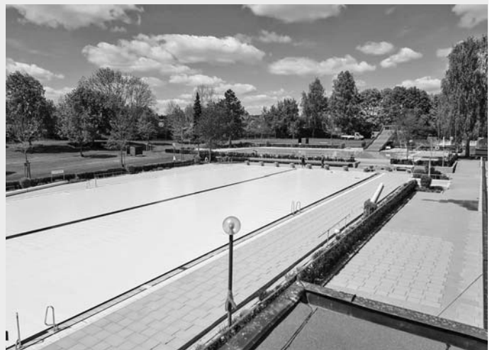
Bereits in diesem Jahr wurde am Schwimmerbecken im Freibad Feuchtwangen eine Abdeckung installiert. Nun wird über die Sanierung und Neugestaltung des Freibades diskutiert.
