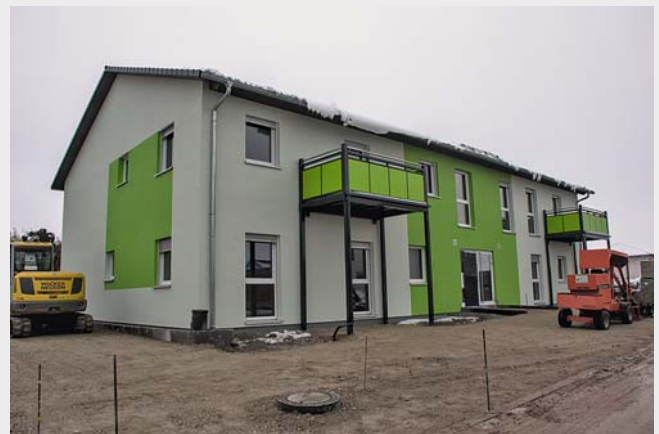
Die Fassade des neuen städtischen Mehrfamilienhauses im „Röschenhof“ strahlt bereits. Lediglich vereinzelte Restarbeiten im Gebäude sowie die Außengestaltung sind in den kommenden Wochen noch zu erledigen.
