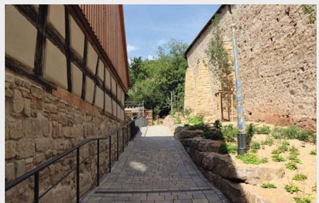
Der neu angelegte Fußweg zwischen der sanierten Nixel-Scheune (links) und der Feuchtwanger Stadtmauer (rechts) ermöglicht ab sofort einen vollständigen Rundgang um die Kreuzgangstadt und bietet mit der neuen Gartenanlage (Titelseite) ganzjährig einen Ort zum Verweilen. Wegen Lieferverzögerungen fehlen derzeit die Lampen noch.
