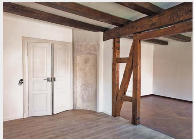
Den ursprünglichen Charme des Einzeldenkmals zu bewahren, war ein großes Anliegen seitens der Stadt und dem Kommunalunternehmen. Originalbalken, Fußböden, Wände und Türen wurden, wie auf dem Foto gut erkennbar, aufbereitet und für die Bewohner sichtbar gemacht.
