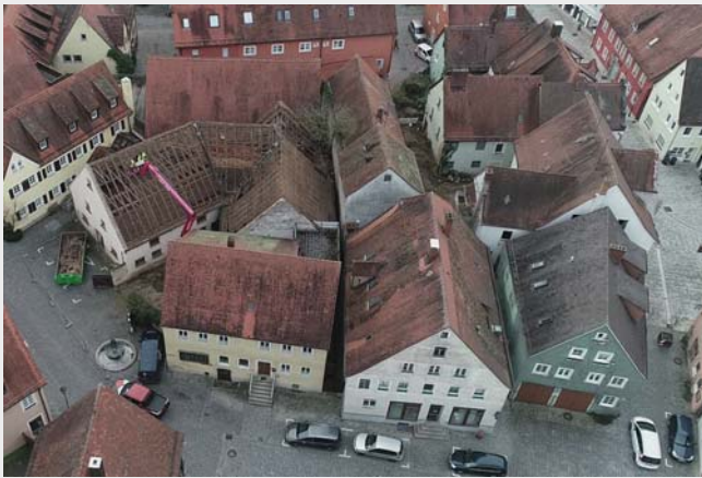
Huppmann-Banse-Areal von oben: die geplanten Abbrucharbeiten haben begonnen und die Dächer des ehemaligen Stalls und der Scheune des Huppmann-Gebäudes (linker Bildrand) sind bereits abgedeckt. Foto: © Werner Tippmann
