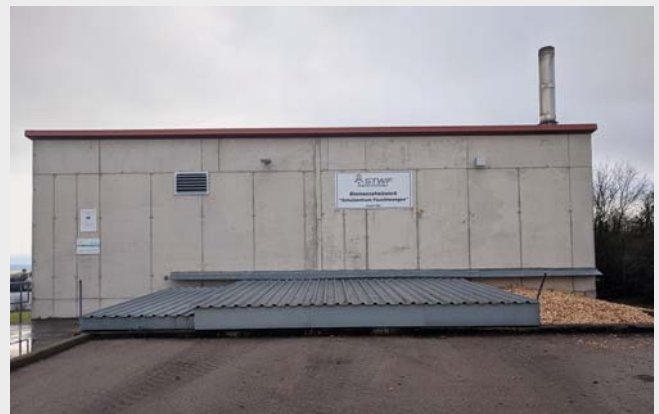
Seit 2007 versorgt die Stadt die öffentlichen Einrichtungen am Schulzentrum über das Biomasseheizwerk nachhaltig mit Wärme.
