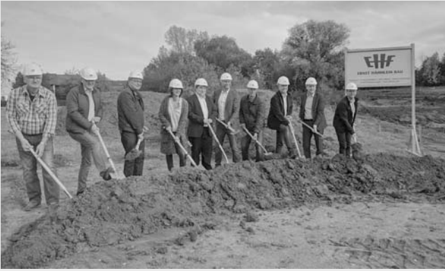
Den ersten Spatenstich setzten (von links) Ortschaftsleiter von Banzenweiler Dieter Wagner, Stadtrat Wolfgang Trumpp, Willi Heller vom zuständigen Planungsbüro, Stadträtin Susanne Friedrich, Pfarrer Jörg Herrmann, Geschäftsführer der zuständigen Baufirma Frank Hähnlein, Zweiter Bürgermeister Georg Sperling, Erster Bürgermeister Patrick Ruh, Landrat Dr. Jürgen Ludwig und Dritter Bürgermeister Herbert Lindörfer.
